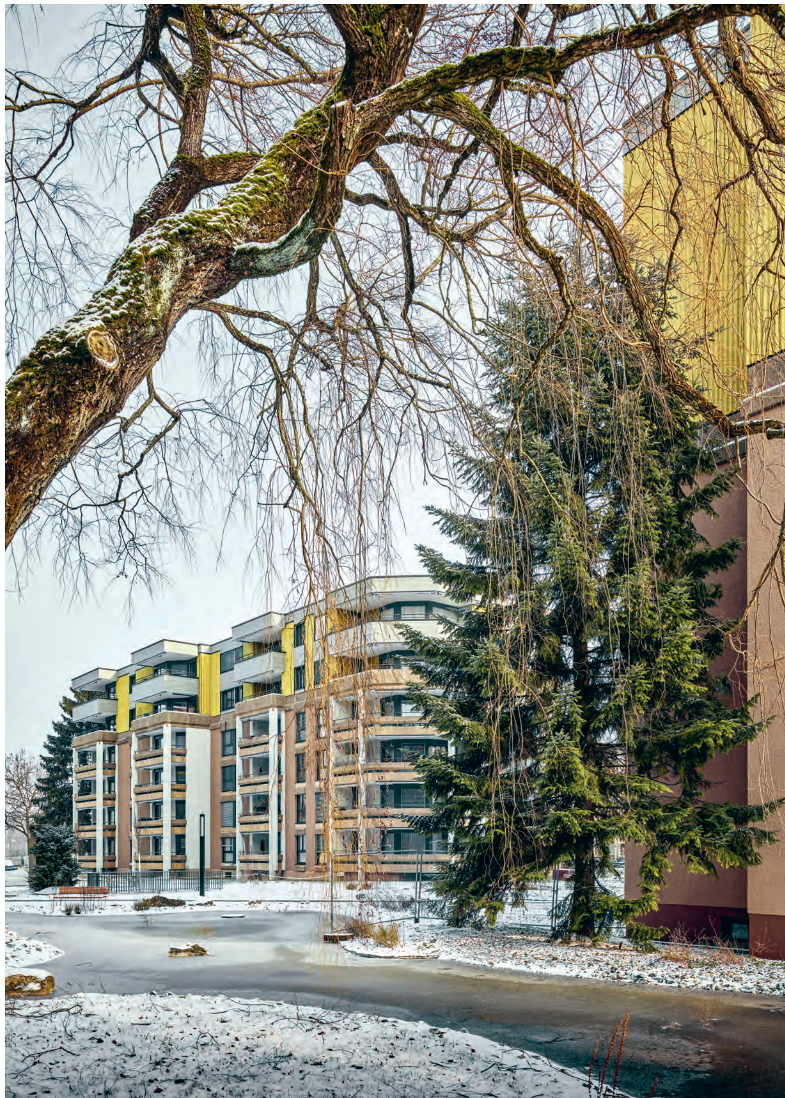
Unterdorfstrasse 31, 33 und – rechts angeschnitten – 37, W2H Architekten: Der Bestand ist weitgehend unverändert, die Aufstockung bildet einen maximalen Kontrast dazu.
