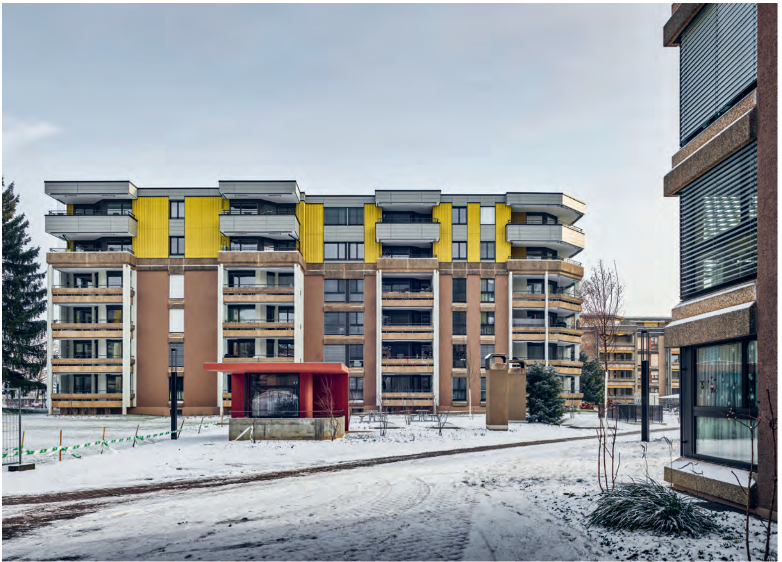
Unterdorfstrasse 27 und 29, Nissille Architekturbüro: Der Bestand ist wie beim W2H-Projekt äusserlich weitgehend erhalten, die Aufstockung verkleidet mit Welleternit.
