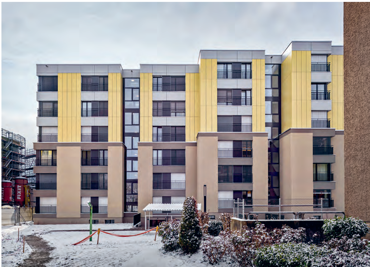
Unterdorfstrasse 47 und 49, HPAG Architektur: Der Bestand verschwindet hinter einer Kompaktfassade und verliert dadurch seine architektonische Kraft.
