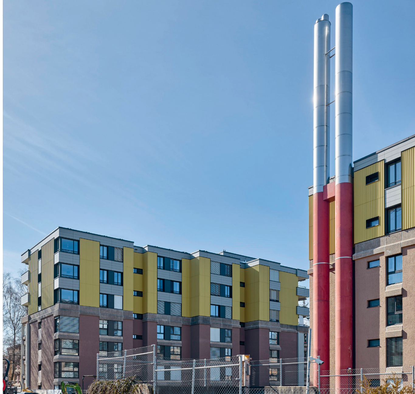
Insgesamt entstehen mit der Aufstockung in Holzbauweise 110 neue Wohnungen. Diese Etappe ist mit einer Fassade aus Eternit verkleidet.
