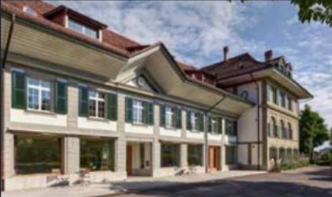
Stirnseite: Die neuen Lukarnen der Dachwohnungen wirken stimmig. Verwendet wurden kupferfarbene Rahmen.
