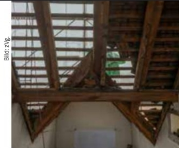
Bei Planung und Umbau kamen im Dach Holzbauten zum Vorschein, die zum Teil aus dem 18. Jahrhundert stammen. Man versuchte, sie zu erhalten und die Wohnungsrisse anzupassen. Manche Holzverstrebungen waren aber morsch und mussten ersetzt werden.
