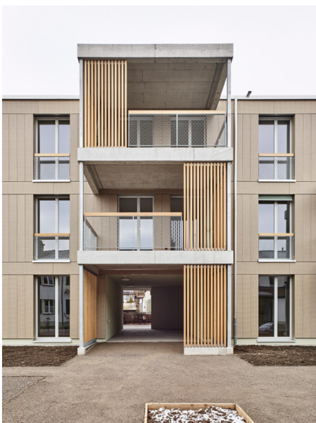
Ausschnitt Fassade Südwest
