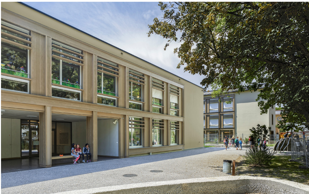
Basisstufe – Eingang und Pausenhalle
