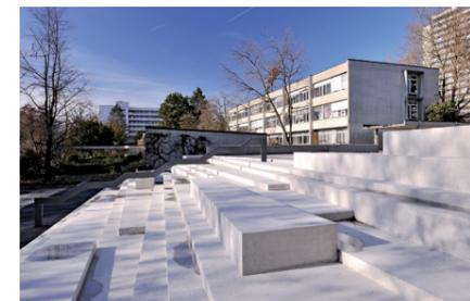
Die begehbare Skulptur besteht aus einer Stapelung und Aneinanderreihung verschiedener Skalierungsformen des Ausgangelements. Die Treppenanlage besteht aus vor Ort gegossenem, hell eingefärbtem und geschliffenem Beton.
